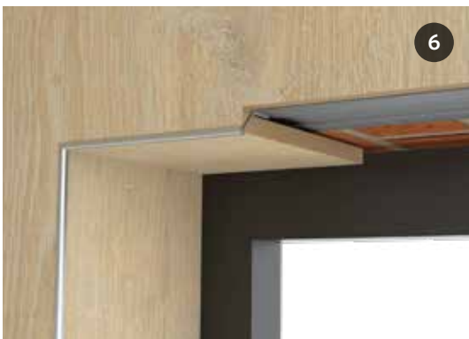
Deurafwerking met aluminium Unilin-profiel.
