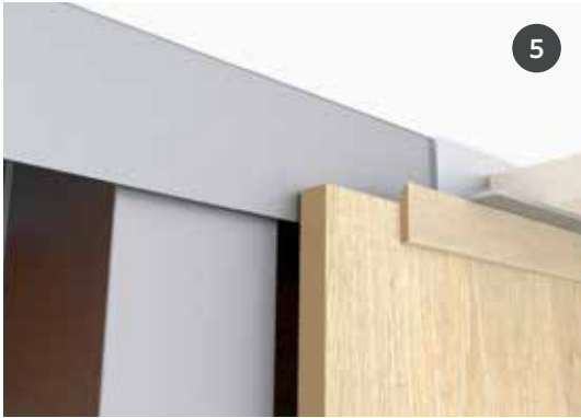
Deckenverarbeitung mithilfe einer Knickleiste
